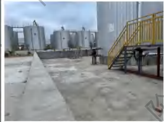
罐区地面硬化
